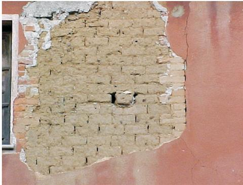
E' di gran lunga la tecnica muraria più utilizzata. I mattoni hanno dimensioni varie, si va dalla misura tipica di tutto il Campidano 40x20x10 cm, fino al 50x25x12cm. Le murature portanti sono realizzate a due teste; l'allettamento di solito è realizzato con terra simile a quella utilizzata per i mattoni, più raramente e nei casi di costruzioni più recenti è riscontrabile l'uso di malta a base di calce.
