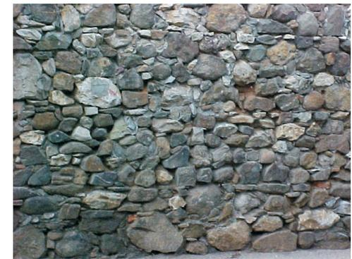
Questo tipo di muratura è utilizzata solitamente per i muri di confine dei cortili, o per il basamento delle murature in terra cruda. Lo spessore della muratura è intorno ai 60 cm, ma contrariamente alle altre murature lapidee, le pietre non sono passanti. Quest'ultime, tondeggianti, non sbozzate e di dimensioni eterogenee, vengono allettate mediante calce e terra.
