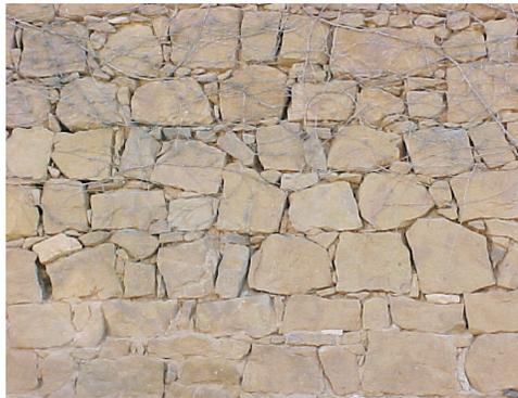
Dopo la terra cruda, questo tipo di muratura è la più utilizzata, sia per i rustici che le murature domestiche. Lo spessore del muro si aggira intorno ai 50-60 cm. I conci di pietra arenaria sono leggermente sbozzati e posti a ricorsi alterni. L'allettamento è realizzato mediante malta a base di calce, con l'inserimento di schegge dello stesso tipo di pietra a riempire i vuoti.
