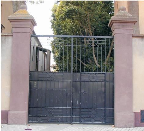
La struttura è composta semplicemente da due piedritti, in mattoni cotti o conci lapidei, senza la struttura orizzontale. Nel caso di abitazioni importanti, la struttura portante è rivestita mediante intonaco e si utilizzano decori particolari.
