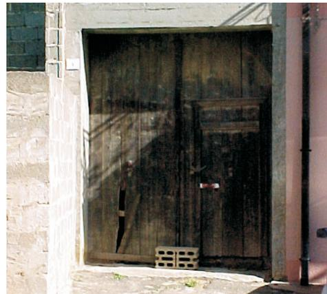
Alla struttura semplice dei piedritti, viene aggiunto l'architrave. Il materiale utilizzato è di solito il calcestruzzo, non lasciato a vista ma spesso intonacato. Il portale è di solito realizzato in legno.
